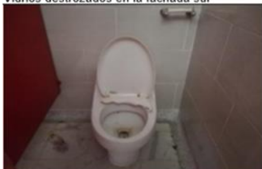
Daños en los sanitarios ocasionados por el vandalismo – desprendimiento de accesorios
