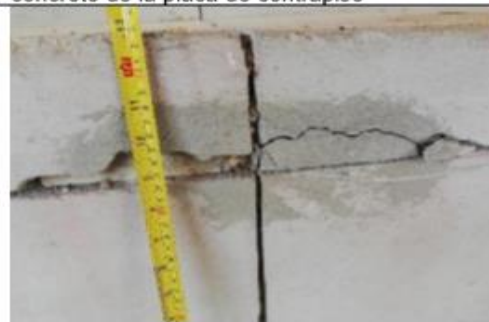
Fisuras y desprendimiento del concreto de las graderías en el costado oriental
