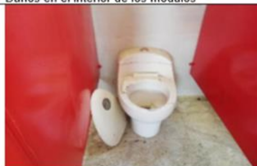
Daños en los sanitarios ocasionados por el vandalismo – desprendimiento de accesorios
