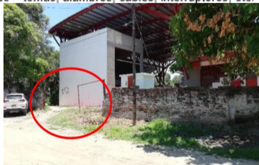
El coliseo se encuentra expuesto al ingreso de cualquier persona o animal, la falta de vigilancia pone en riesgo los elementos y accesorios que se encuentra dentro del coliseo
