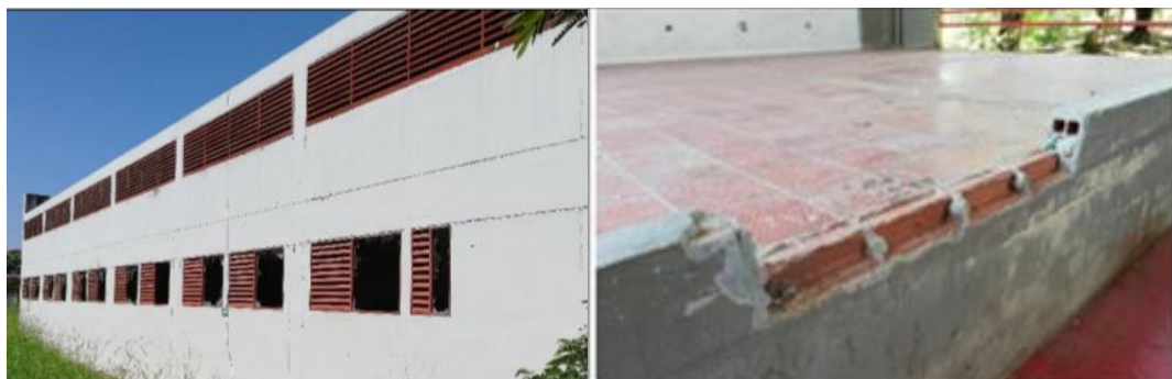
Humedad en graderías desde la viga canal
