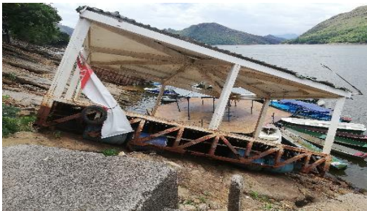
Plataforma del muelle No. 3 en proceso de descomposición y en abandono
