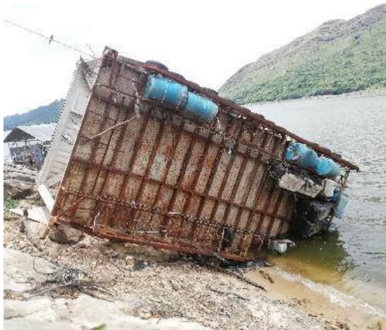
Plataforma del muelle No. 2 volcado, dañado, destrozado y con pocos flotadores
