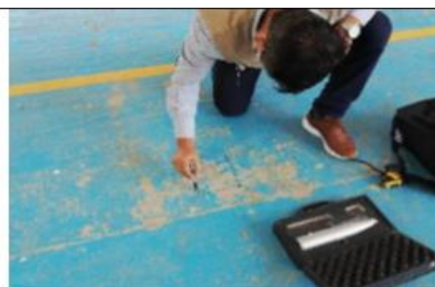
Se realizaron pruebas de resistencia del concreto de la placa de contrapiso
