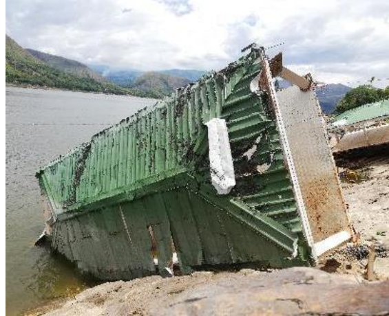
Plataforma del muelle No. 2 volcado, dañado, destrozado y con pocos flotadores
