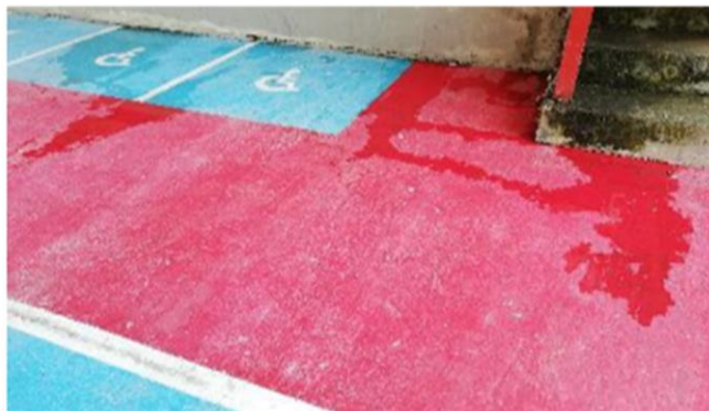
Humedad en graderías desde la viga canal
