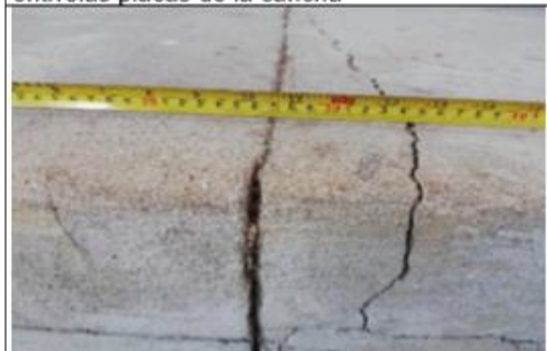
Fisuras y desprendimiento del concreto de las graderías en el costado oriental
