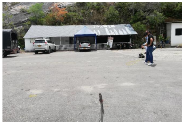
Carpeta asfáltica instalada en el malecón, se tomaron medidas para cuantificar el ítem
